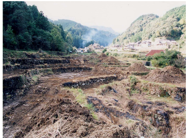
▲整地前の枝川内区の様子
